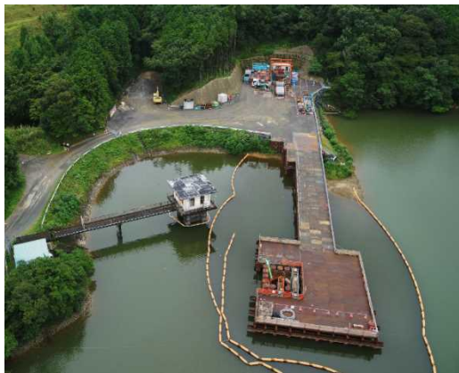
写真-1 工事箇所全景
