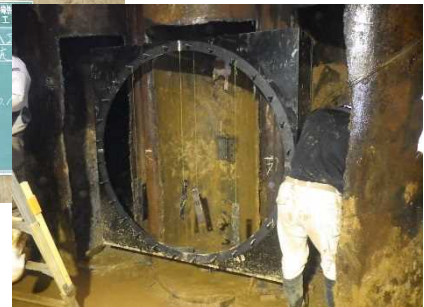
写真-3 鋼管矢板坑口設置状況
