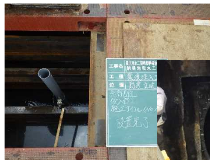
写真-2 塩ビ管 VU75 設置状況
