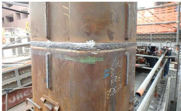
写真-6 柱現場溶接完了・エレクションピース切断
