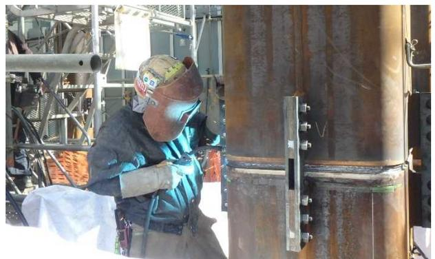
写真-5 柱現場溶接状況
