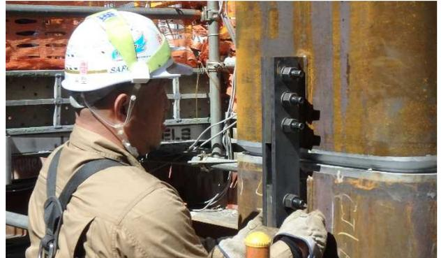
写真-3 柱仮ボルト締め状況
