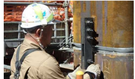
写真-3 柱仮ボルト締め状況
