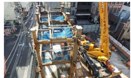
写真-4 1工区1節建方状況
