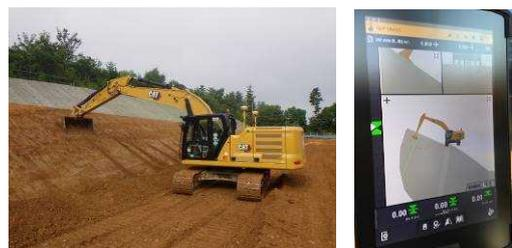
写真-3 MGバックホウによる法面整形状況
