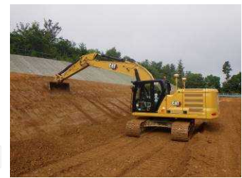
写真-2 マシンガイダンス バックホウによる法面整形状況
