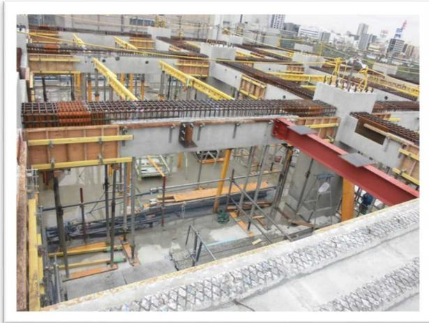
写真-14 現場支保工設置状況
