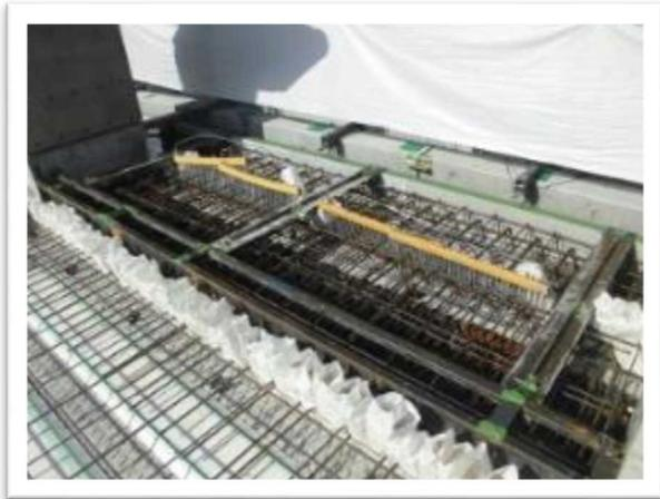
写真-2 鋼製型枠セッ完了
