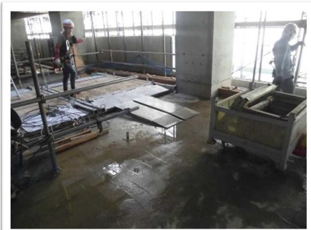
写真-15 荷揚げステージによる作業状況 1
