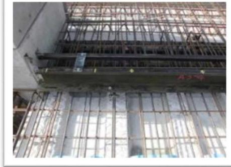
写真-2 鋼製型枠の柱固定
