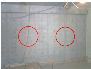
写真 5-1 ひび割れの補修事例
