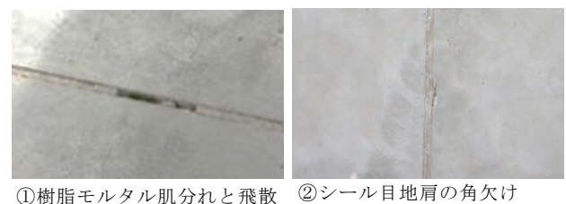
図 5-4 床目地施工状況
