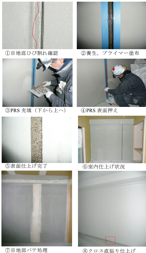
図 5-2 PRS の施工手順
