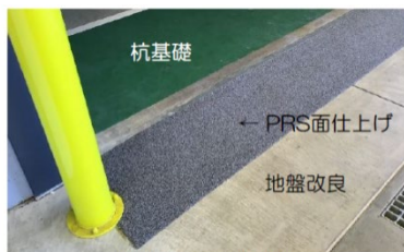
床段差15mmの解消例
