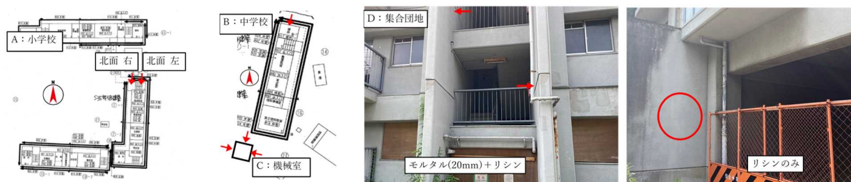
図-1 対象建築物の調査およびコア採取位置
