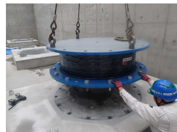
写真-2 積層ゴム受け入れ検査
