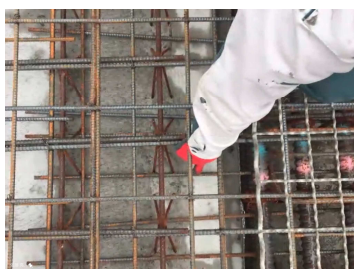
写真-4 配筋検査状況
