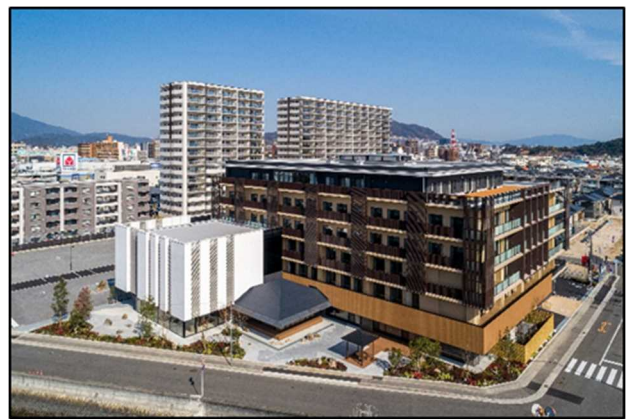
写真-1 本建物全景
