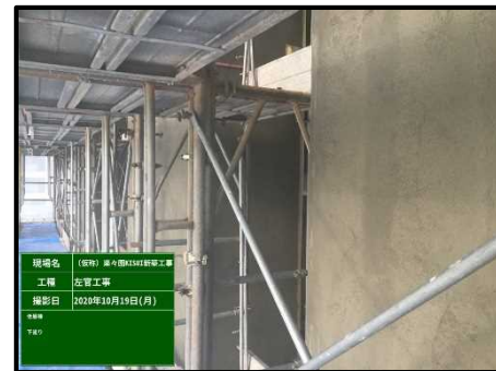
写真-7 ジョイントV下地処理状況
