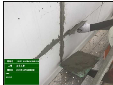
写真 - 6 ジョイント目地処理状況
