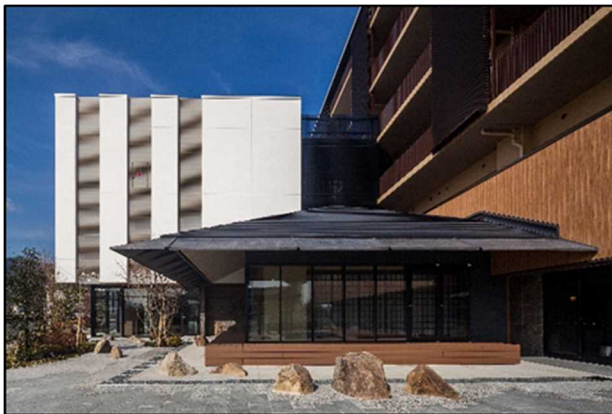
写真-11 南面 白しっくい風壁仕上状況
