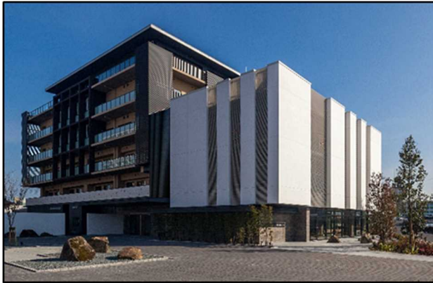
写真-9 北西面 白しっくい風壁仕上状況
