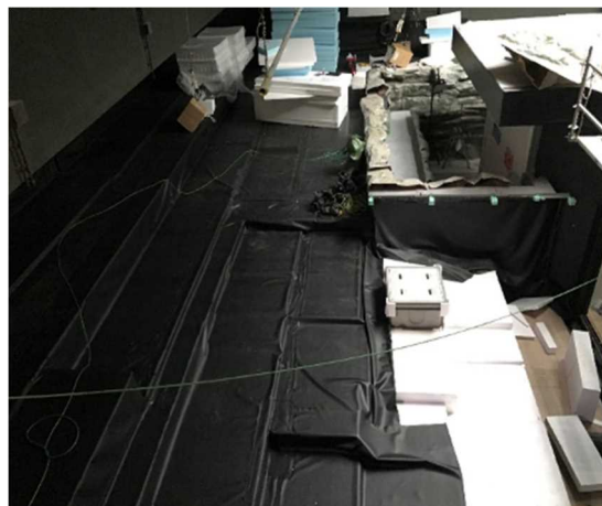
写真-17 ジャングルエリア施工 6
