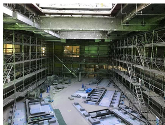
写真-13 ジャングルエリア施工 2
