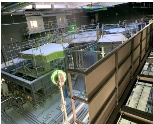
写真-15 ジャングルエリア施工 4
