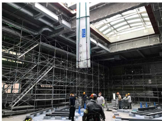
写真-8 アクリル板搬入状況
