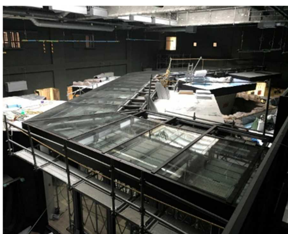
写真-16 ジャングルエリア施工 5
