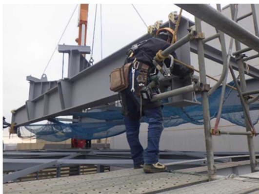
写真-1 クレーン基礎設置状況
