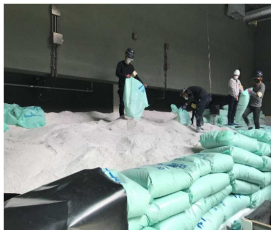
写真-18 ジャングルエリア施工 7
