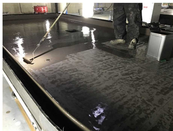
写真-6 防水 FRP 施工状況
