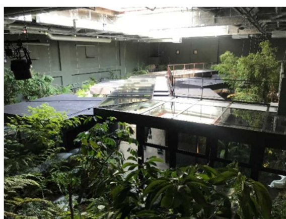
写真-19 ジャングルエリア施工 8
