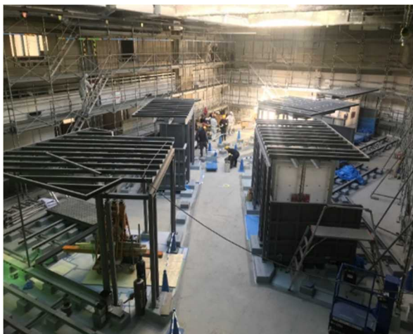
写真-14 ジャングルエリア施工 3
