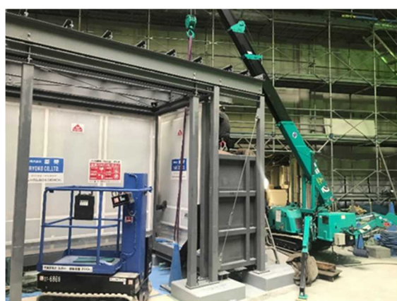
写真-9 アクリル板設置状況
