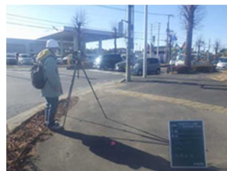
図-13 点群計測状況 (工事 3)
