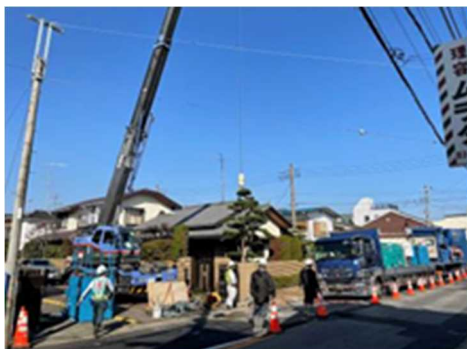
図-6 現場施工状況
