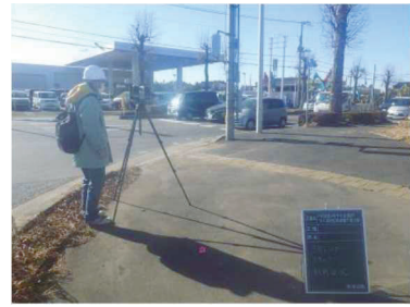
図-5 点群計測状況（工事3）
