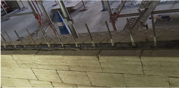
(馬目地壁への還土ブロックの組積状況)
