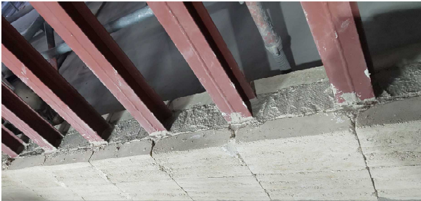
(芋地壁への還土ブロックの組積状況)
