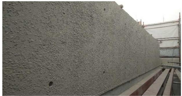
写真-2 西面手すり壁(目荒らし処理後)
