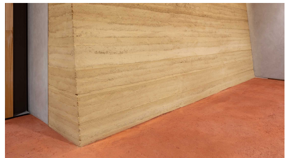
写真－2 薄型版築壁施工後の状況
