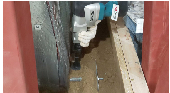
写真－1 薄型版築壁の施工状況
