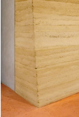
写真-1 薄型版築壁
