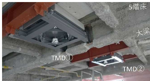
写真 3 TMD①②の設置状況
