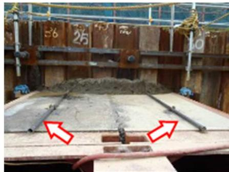
写真-5 注入管設置状況（φ30有孔管）
