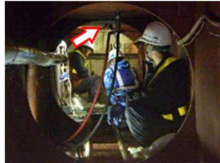
写真-4 可塑剤注入状況（角型鋼管内）
