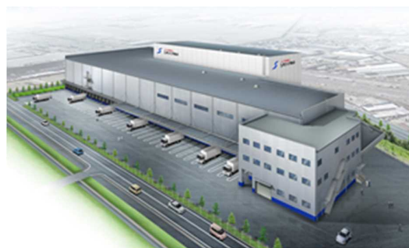
写真-1 竣工時建物
