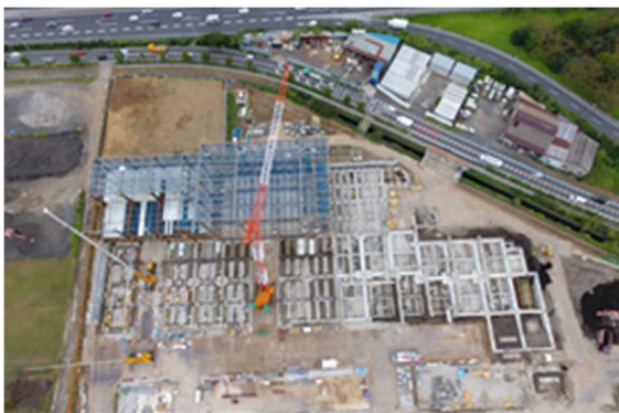
写真-13 鉄骨建て方状況④ (2019.9)
