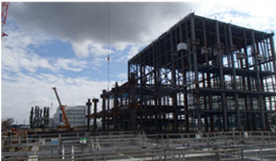
写真-12 鉄骨建て方状況③
