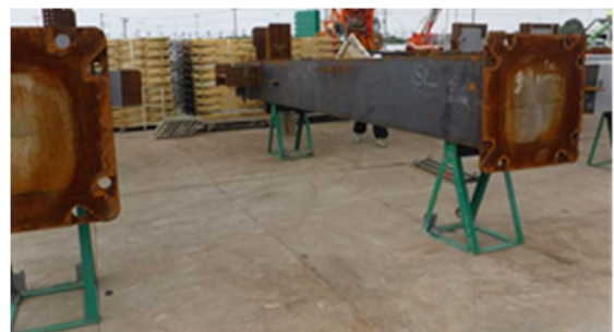
写真-9 鉄骨建て方状況（ボックス）
