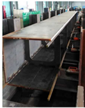
形維持板を入れてBOX組立
