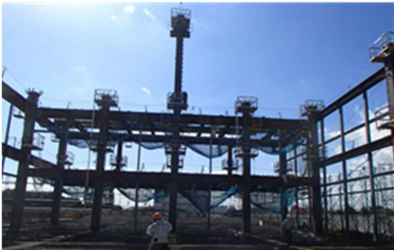
写真-11 鉄骨建て方状況②
