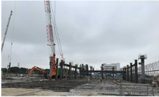
写真-10 鉄骨建て方状況①
