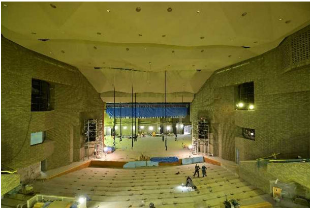
図-31 大ホール（足場解体後）
