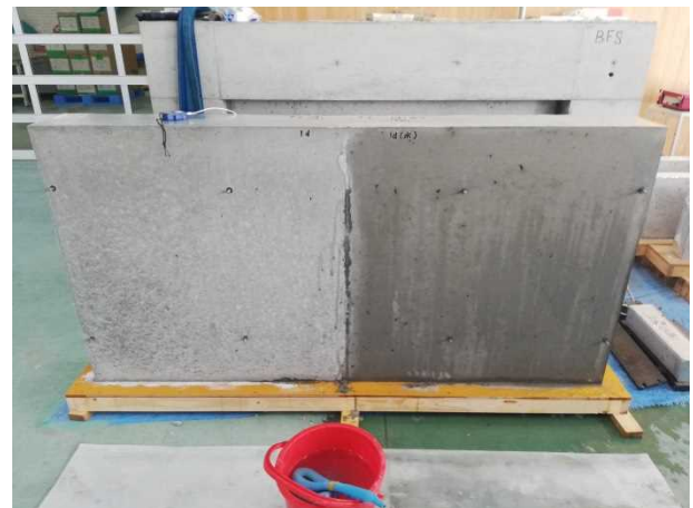
写真-2 模擬壁の養生状況（右半分散水実施）
