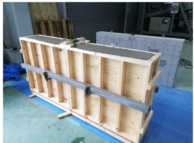
写真-1 模擬壁打込み完了状況
