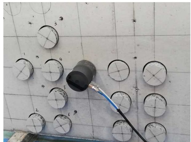
写真-3 コア供試体採取と透気試験実施状況
