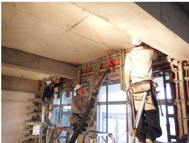
写真2 シャッターバルブを使用した打込み状況および型枠の設置状況
