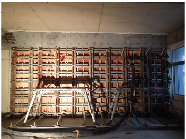
写真2 シャッターバルブを使用した打込み状況および型枠の設置状況
