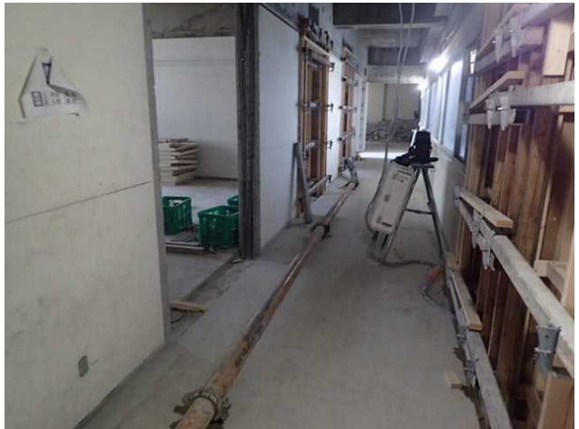
写真1 打込み状況および輸送管の設置状況
