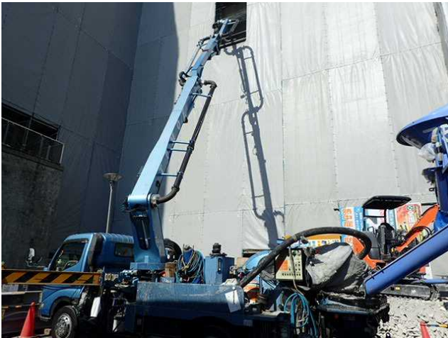
写真1 打込み状況および輸送管の設置状況
