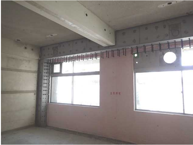
写真3 スムースフィルクリートの出来形状況
