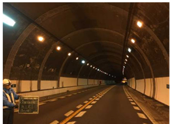
写真-8 完了全景
