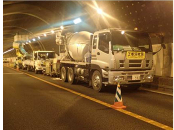
写真-6 集中工事 注入状況
