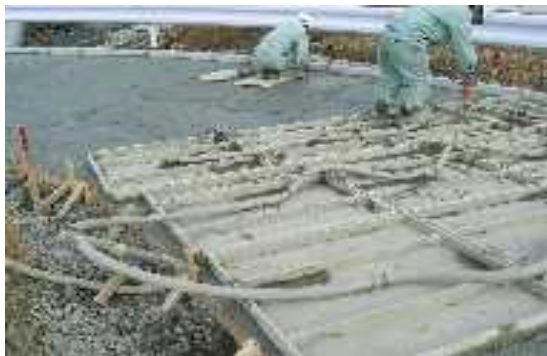
写真-1 真空コンクリート
