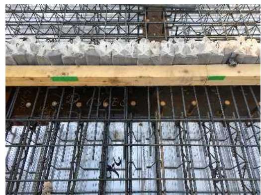
写真-7 打継部状況
