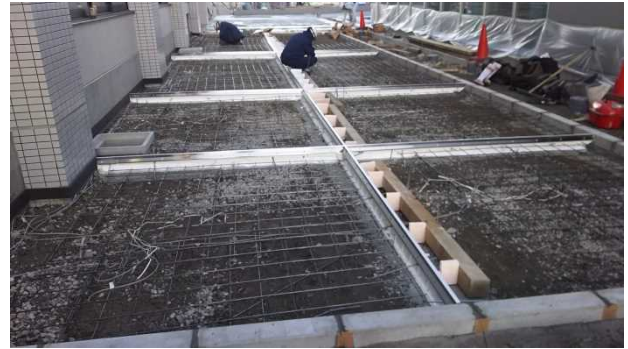
写真-3 1 DAY PAVE 打込み前
