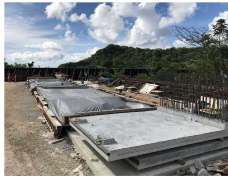
写真-17 PCa 製作ヤード
