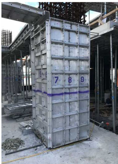
写真-8 柱型枠ナンバー付け状況
