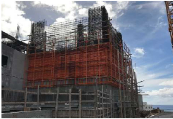
写真-11 ガンフォームの設置状況
