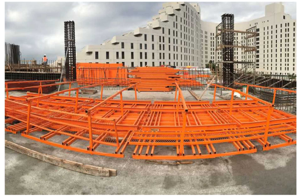
写真-12 ガンフォーム地組の状況
