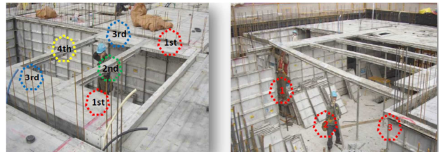
写真-4 梁・スラブ受け建て込みの例
