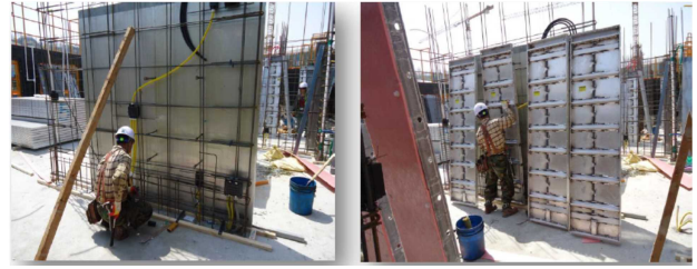
写真-3 壁アルミ型枠建て込みの例
