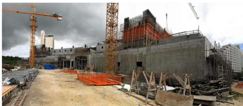
写真-22 2018/5 全景写真 2
