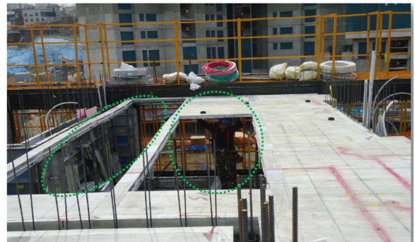
写真-5 スラブ受け建て込みの例
