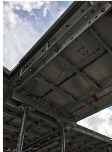
写真-9 梁型枠組立状況
