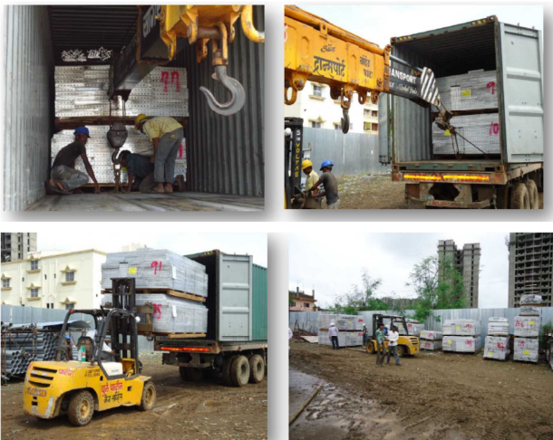
写真-1 アルミ型枠荷姿の例
