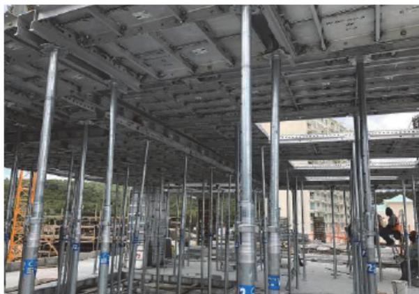
写真-1 アルミ型枠
