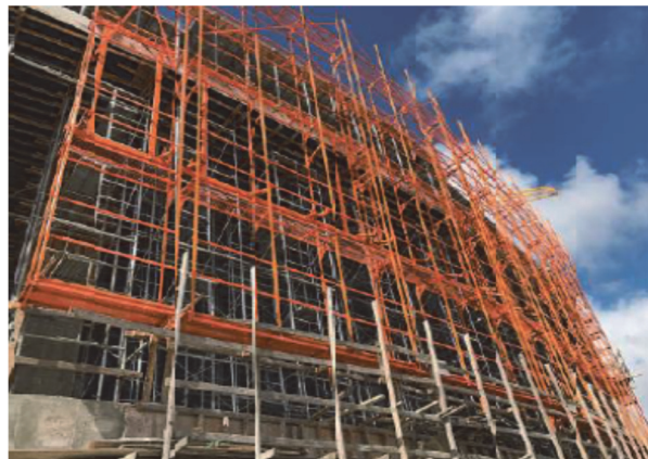
写真-2 バルコニーゲージ (せり上げ式外部足場)
