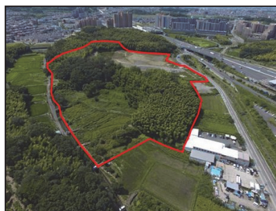
写真－1 着工前現況
