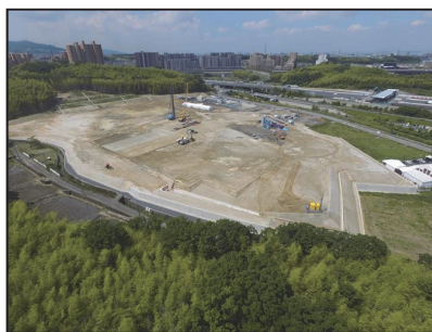
写真－2 造成工事完了
