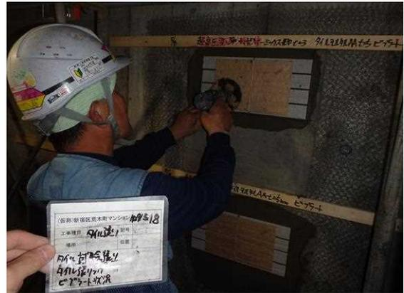
写真-5 振動工具加振状況
