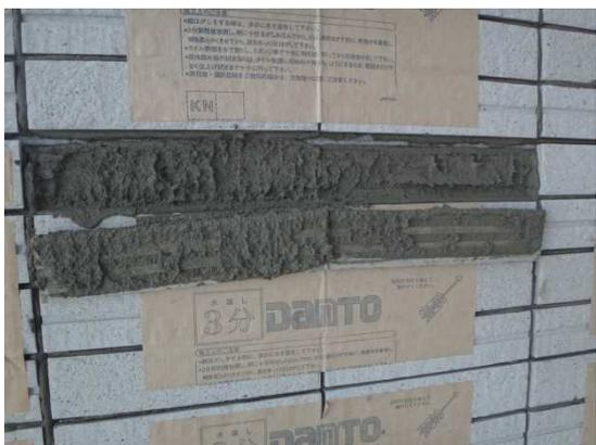
写真-11 充填率確認状況
