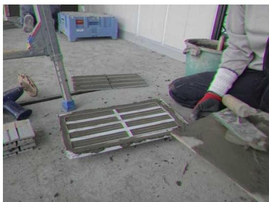
写真-9 タイル裏面へのモルタル塗り状況
