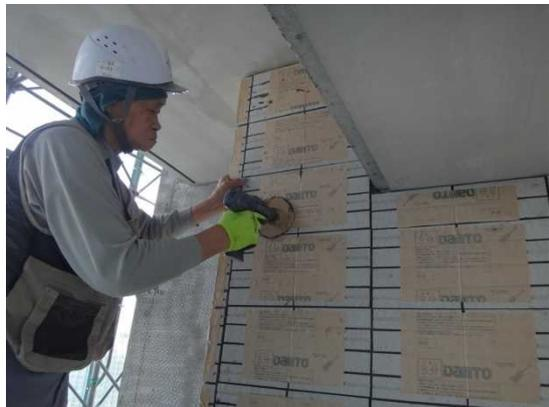
写真-10 振動工具による加振状況
