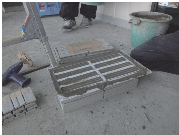
写真－1 簡易マスクによる張付けモルタル塗付け状況
