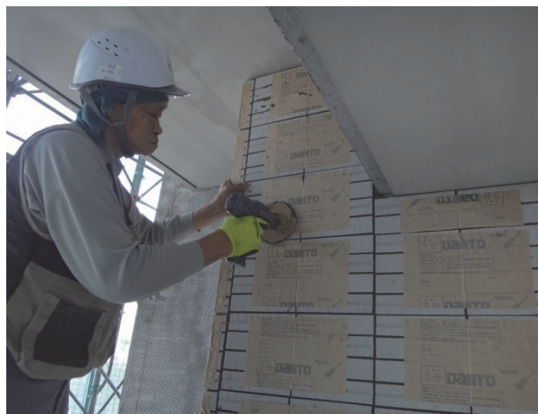
写真－2 振動工具（ヴィブラート）による加振状況
