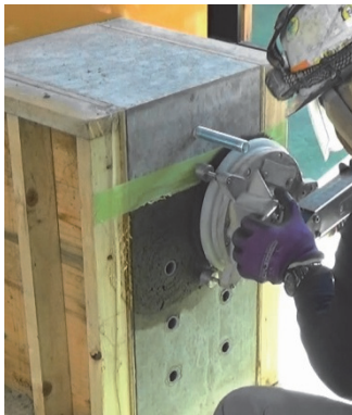
写真－1 超高压水による表面処理
