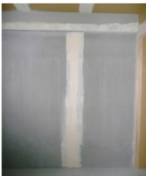
⑦目地部パテ処理
