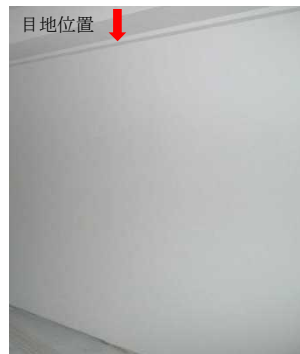
⑧クロス直貼り仕上げ (洋室)
