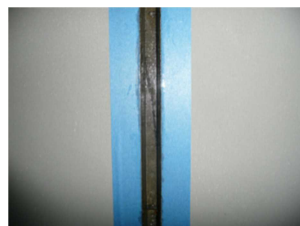
②プライマー塗布 (3面接着)
