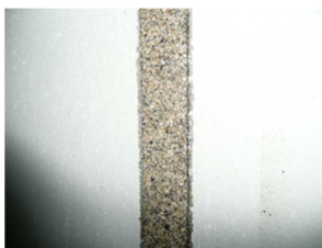
⑤表面仕上げ完了後
