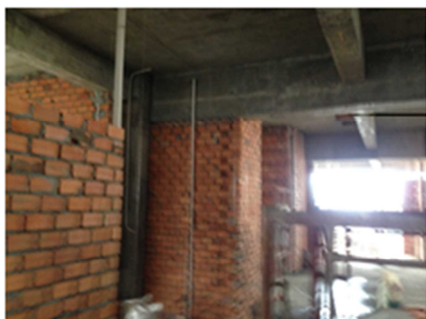
間仕切り施工状況(ブリック)
