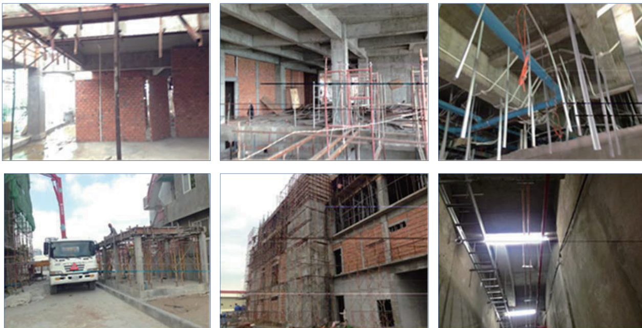
写真 施工中の現場状況
