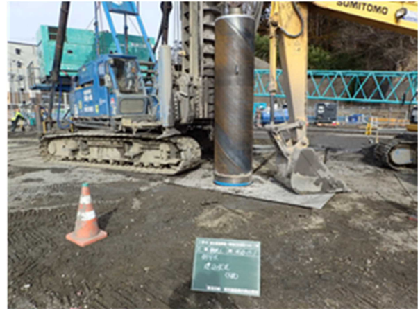
写真-1 CRID 工法施工状況
