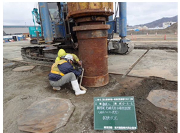
写真-2 先端支持力確認状況
