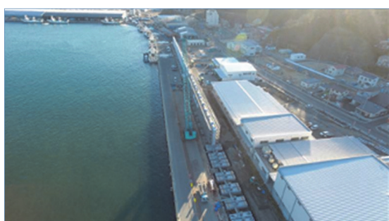
写真－2 施工状況（1工区～4－①工区）
