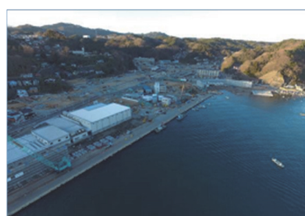
写真－3 施工状況（4－②～5工区）
