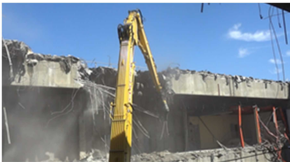
写真-6 PC 梁解体状況（支保工無し）
