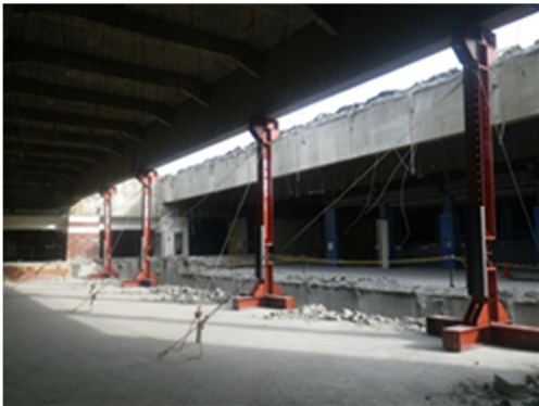
写真-4 支保工設置状況
