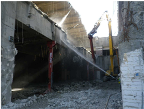
写真-5 支保工転用状況
