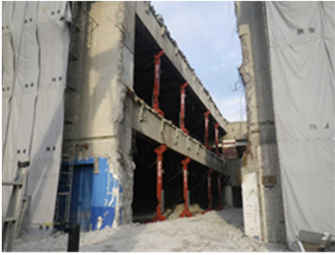
写真-3 支保工設置状況
