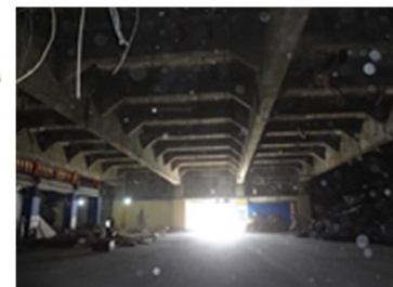
写真-2 PC 梁の状況
