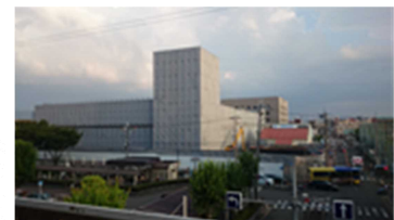
写真-1 解体工事前建物外観
