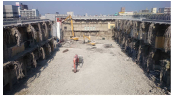
写真-7 PC 梁解体終了状況
