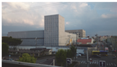
写真－1 解体工事前建物外観
