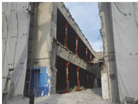
写真－3 支保工 設置状況
