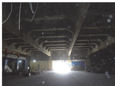
写真－2 PC梁の状況
