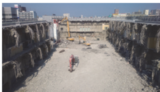
写真－4 PC梁解体 終了状況
