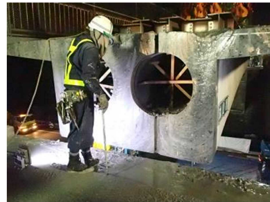
図-7 ワイヤソー切断面
