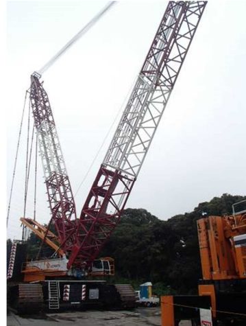
図-6 1000t 吊級クレーン
