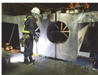
写真ー1 ワイヤソー切断面
