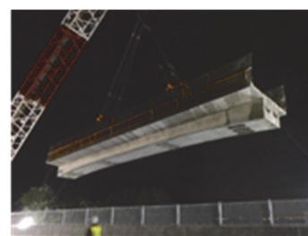
写真ー2 1000t吊級クレーンでの一括撤去
