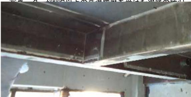
写真-2 600℃以上の高温履歴を受けた梁底の状態
