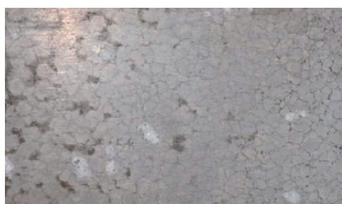
写真-1 火災による亀甲状の微細ひび割れ
