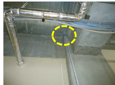
写真-4 梁とフェローデッキの取合い部
