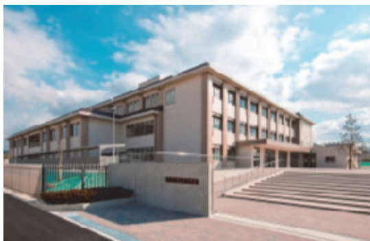
写真-1 校舎棟全景
