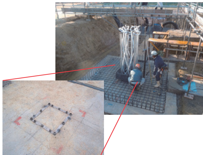
写真-2 基礎内柱用P C鋼棒の位置決めテンプレート
