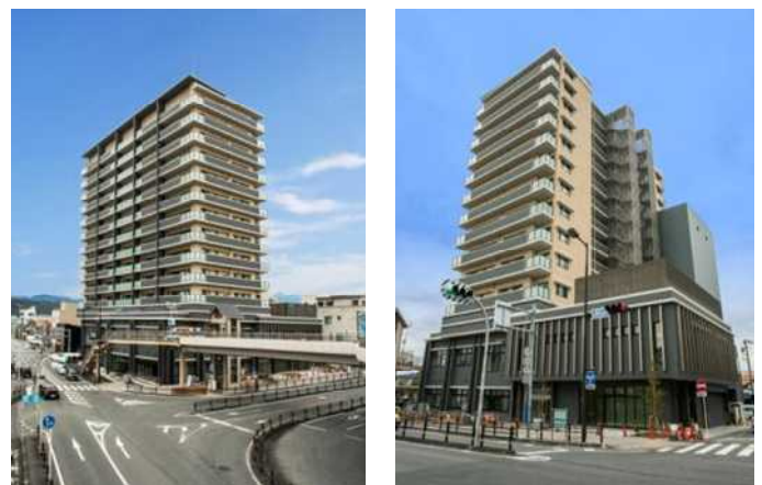
写真一1 建物全景
