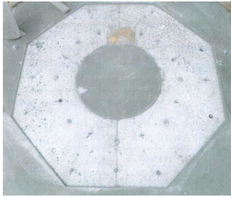
写真-2 コンクリート表面
