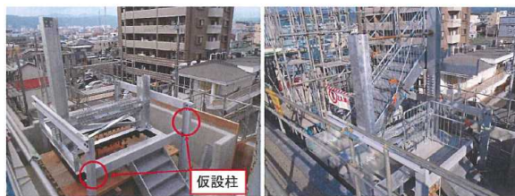
写真-5 屋外鉄骨階段の施工状況
