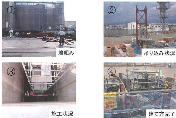
写真-4 EV シャフト内の鉄骨フレーム建て方
