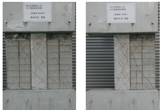
写真－1 最終破壊状況
