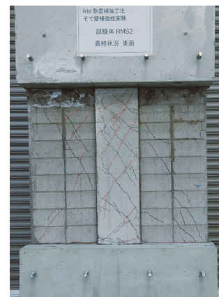
写真－3 破壊状況
