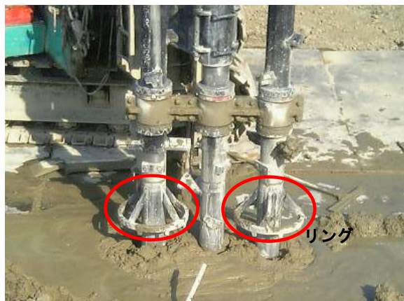
写真-2 特殊三軸オーガーによる攪拌状況
